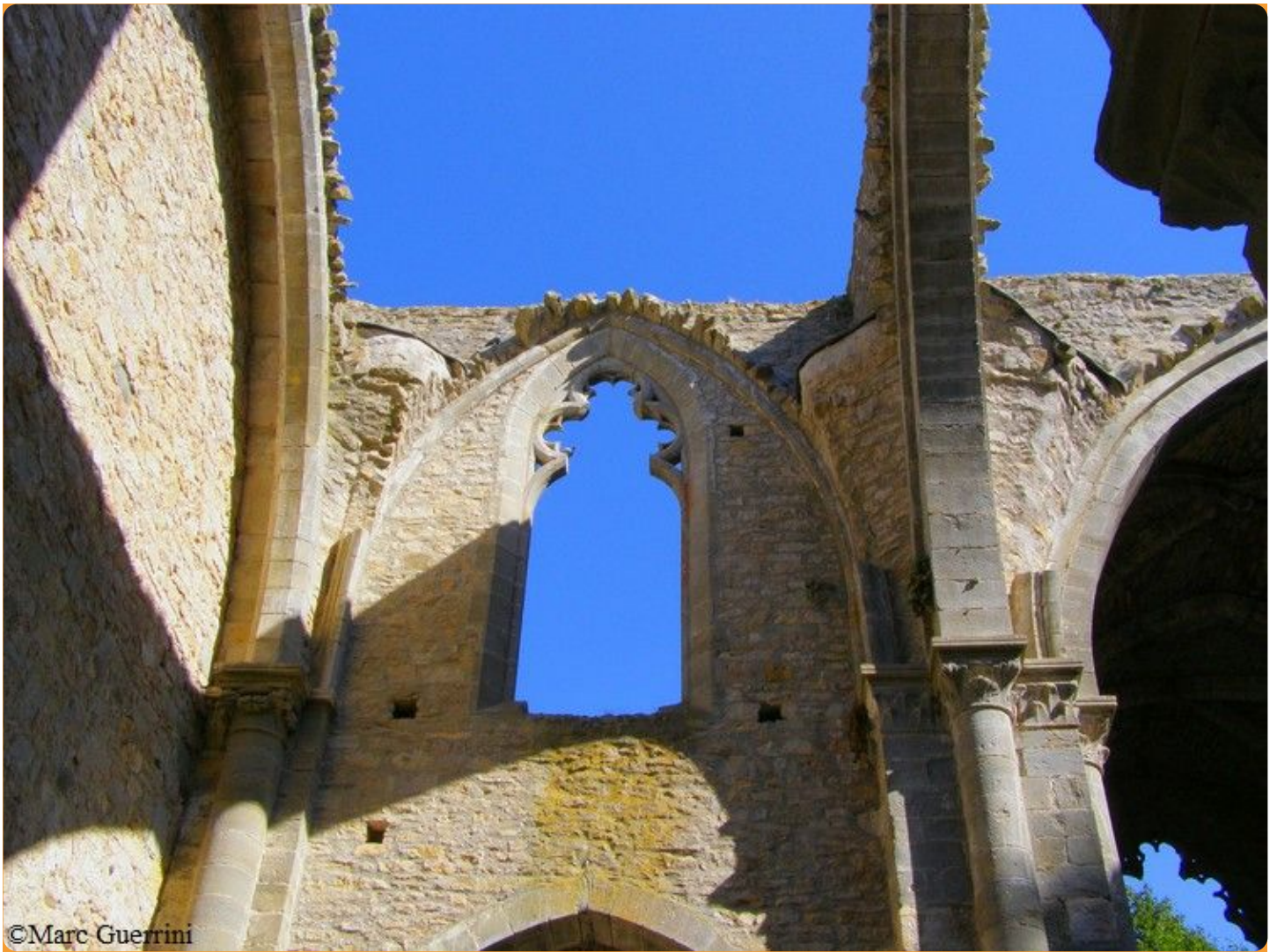
L'intérieur de l'église abbatiale avec ses immenses baies gothiques éclairant jadis le transept
